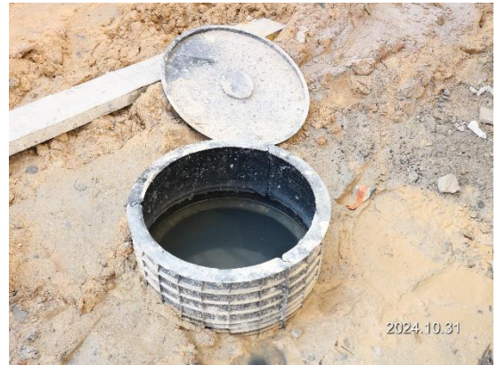
รูปที่ 3-13 ถังบำบัดน้ำเสียสำเร็จรูปแบบเดิมอากาศ
