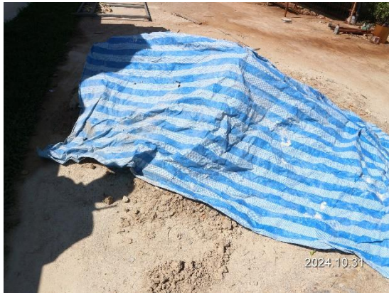
รูปที่ 3-1 กองเก็บดินเป็นสัดส่วน และมีผ้าปิดปกคลุม
