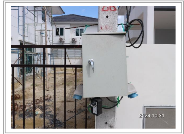
รูปที่ 3-19 อุปกรณ์ตัดไฟฟ้าอัตโนมัติ
