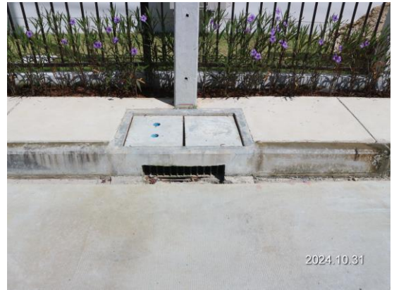
รูปที่ 3-2 ท่อและรางระบายน้ำถาวรโดยรอบโครงการ
