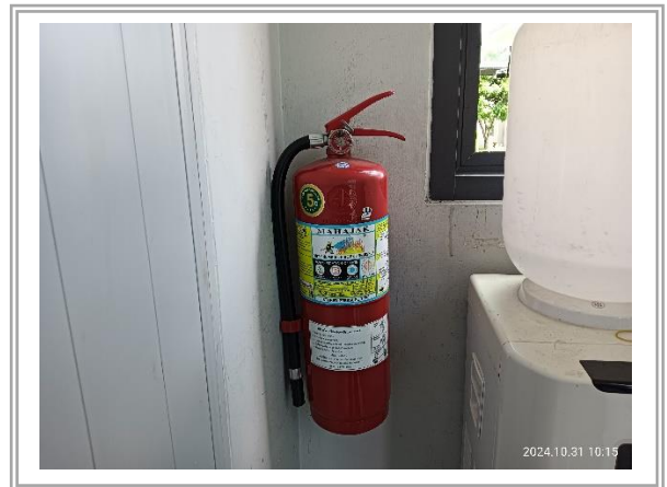
รูปที่ 3-21 ถังดับเพลิงแบบมือถือชนิดผงเคมี
